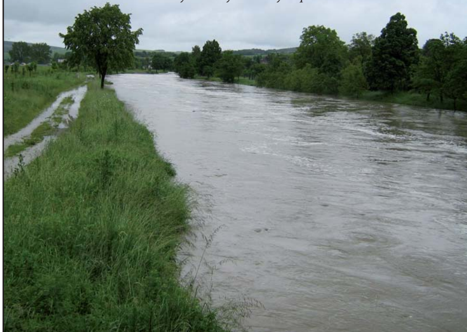
Povodně 2010 v obci Podolí – když se koryto Olšavy naplnilo.
